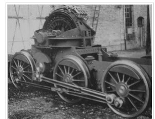
Schrägstangenantrieb an einem der beiden laufachslosen Drehgestell der BLS Probelokomotive Ce 6/6 151 im Jahre 1910.
