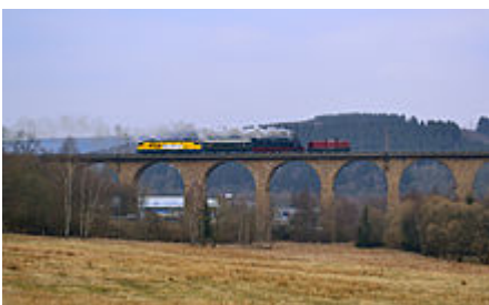
Die V 100 2335 der NeSa mit einem Überführungs-Lokzug auf dem Rudersdorfer Viadukt.
