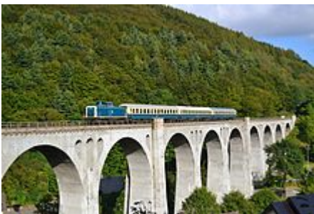
Ein Sonderzug mit 212 376-8 im September 2012 auf dem Willinger Viadukt.
