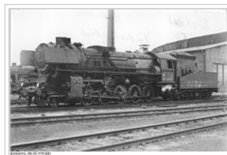
Rückgebaute 52 Kon bei der DR, die Saugzugturbine und die höhere Lage des Umlaufes ist erkennbar
