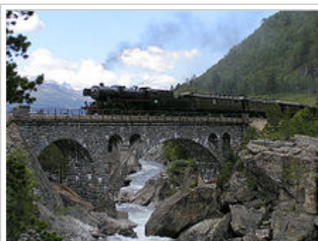
63a-2770 auf der Stuguflåtbrua, Raumabanen, 2004
