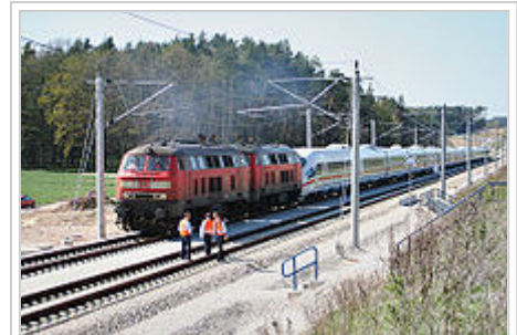
Zwei Lokomotiven der Baureihe 218 schleppen in Doppeltraktion eine ICE-3-Doppelgarnitur auf der Neubaustrecke Ingolstadt – Nürnberg ab.
