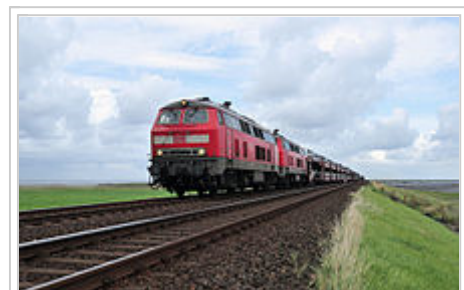
Der Hindenburgdamme mit dem Sylt Shuttle, der von 218 315-0 und einer zweiten 218 gezogen wird
